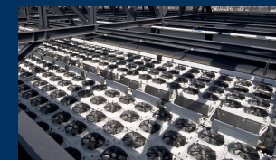
Peiner Träger steelworks Salzgitter, Germany
